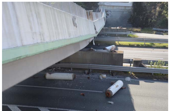
写真2 本震で九州自動車道上に落橋した跨道橋
