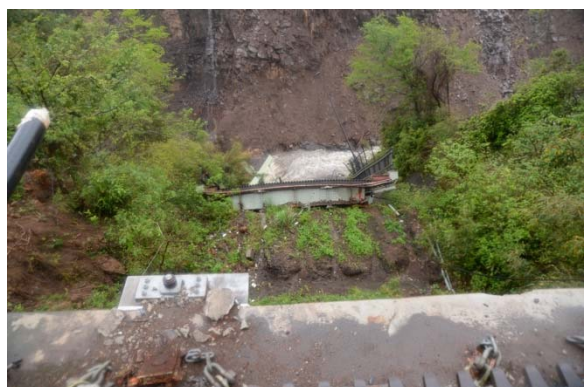
写真3 大規模斜面崩壊により流出した 阿蘇大橋の一部
