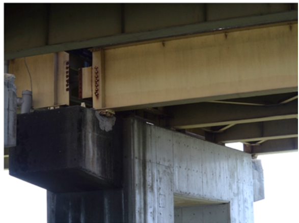
写真1 前震で落橋寸前の被害を受けた 高速道路高架橋
